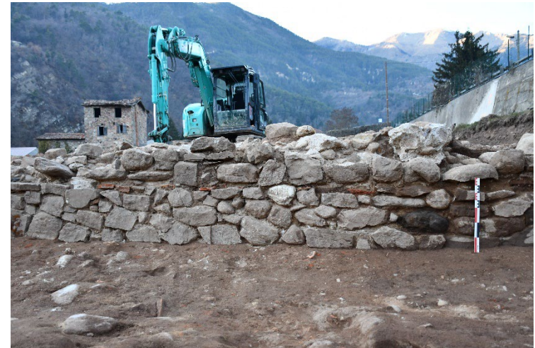
Plusieurs assises conservées en élévation
