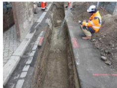
Strasbourg – Extension ligne G, BHNS
